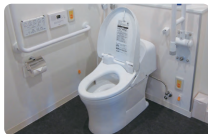
多目的トイレ(橋本支店)
