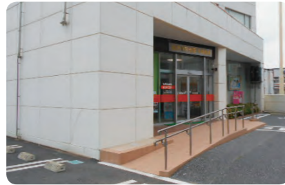
店舗入口スロープ(千湯支店)
