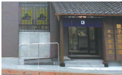
店舗入口スロープ(大多喜支店)
