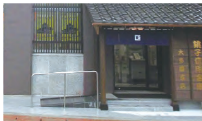
店舗入口スロープ(大多喜支店)
