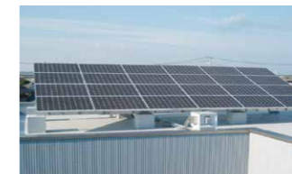
太陽光発電パネル(松岸支店)
