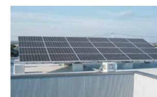
太陽光発電パネル(松岸支店)
