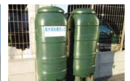
節水用雨水タンク
