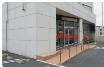
店舗入口スロープ(千湯支店)
